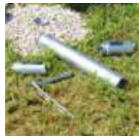
defekten Schilderpfosten abflexen
