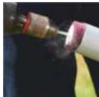
Schnittfläche Pfostenrohr säubern
