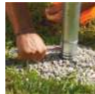
Beide Teile mit Gelenkteil AUGUSTAFLEX verbinden und mit Spezialschlüssel festziehen
